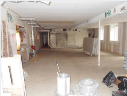
Vloeren zijn gelegd
